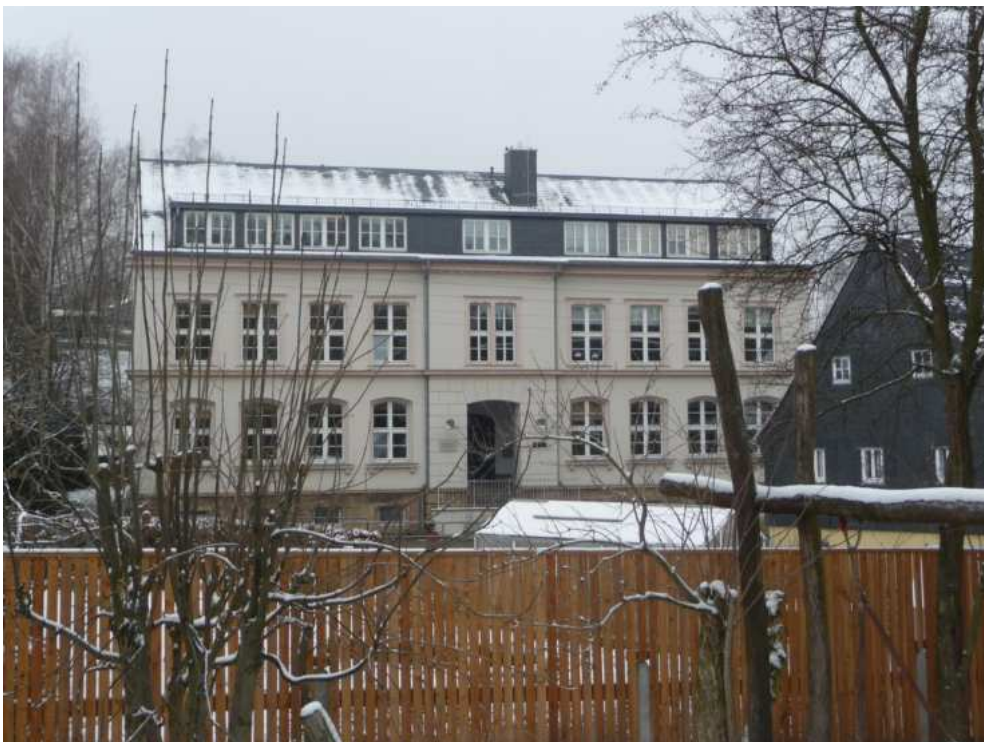
Unser Blick zur Grundschule Adelsberg
